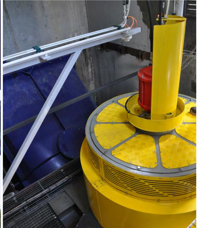
▲ Un alternateur à aimants permanents Bernard Bonfond a remplacé l'ancienne génératrice asynchrone qui nécessitait un multiplicateur.
