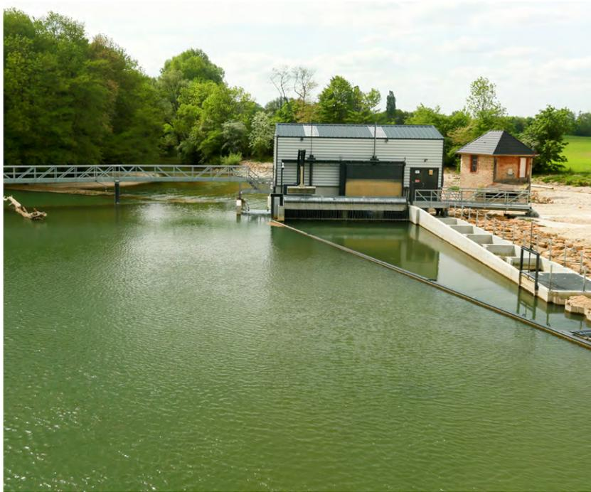
▲ La prise d'eau est protégée par une drome et par une grille de 9,40 m par 3,86 m avec 10 cm d'écartement entre les barreaux, nettoyée par un dégrilleur automatique. Photo : Berti Hanna
