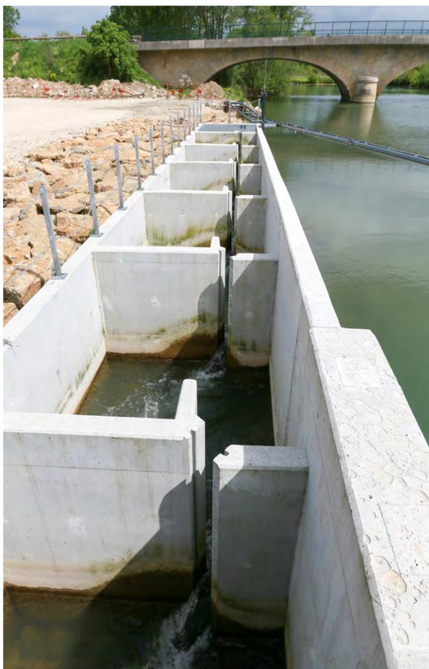
▲ La passe à poissons mesure 49 m de longueur par 2,80 m. Elle compte 14 bassins successifs (3,20 m par 2,80 m) avec un débit de 400 l/s pour une chute brute de 3,50 m. La chute entre bassins est de 17 cm.
