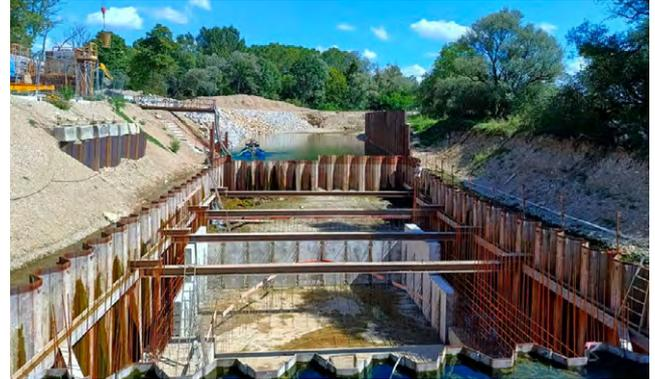
▲ Chantier de construction de la centrale d'Ounans (Jura), sur la Loue (499 kW, 30 m<sup>3</sup>/s, 3 m de chute). Photo : Fabrice Bouveret
