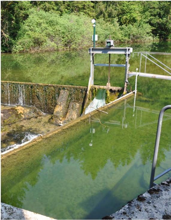
▲ La vanne du barrage, qui garantit notamment le niveau des hautes eaux, a été automatisée et dotée d'une caméra.
