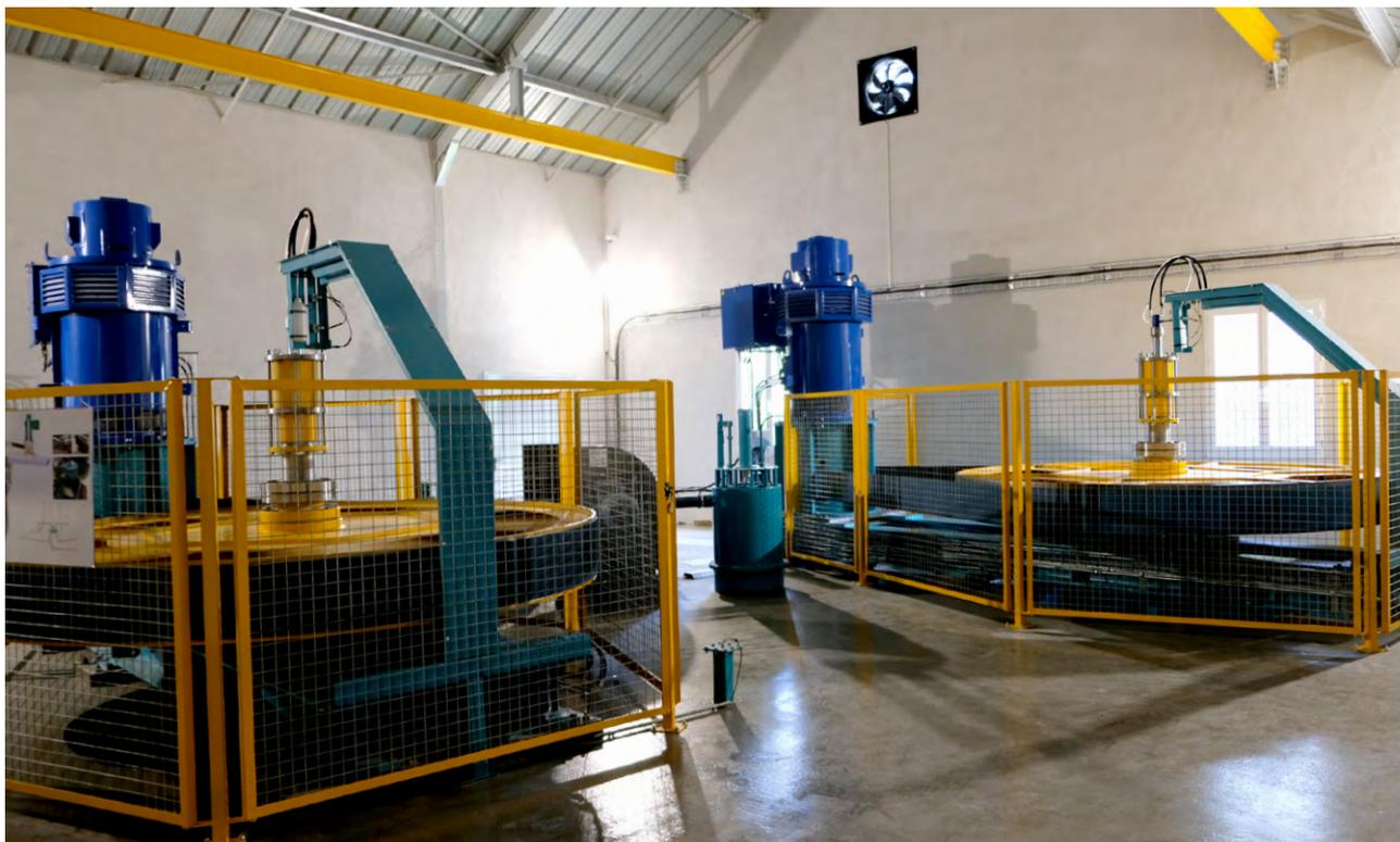
▲ Les 2 turbines sont des Kaplan simple réglage, avec poulie-courroie, construites par les Ets Ballet Constructions (Noidans-lès-Vesoul, Haute-Saône).
