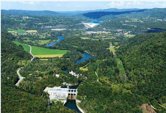
▲ Dans les prochaines années, EDF Hydro installera une turbine-pompe de 16 MW au barrage de Saut-Mortier (44 MW aujourd'hui), en aval de la retenue de Vouglans, pour produire 200 GWh/an d'hydroélectricité supplémentaire et améliorer le multi-usage de l'eau de la vallée de l'Ain. Photo : EDF Hydro
